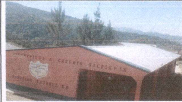
FOTO 1 Sustitución de lámina, por lámina troquelada aluzinc calibre 26, el aula 1 y 2
